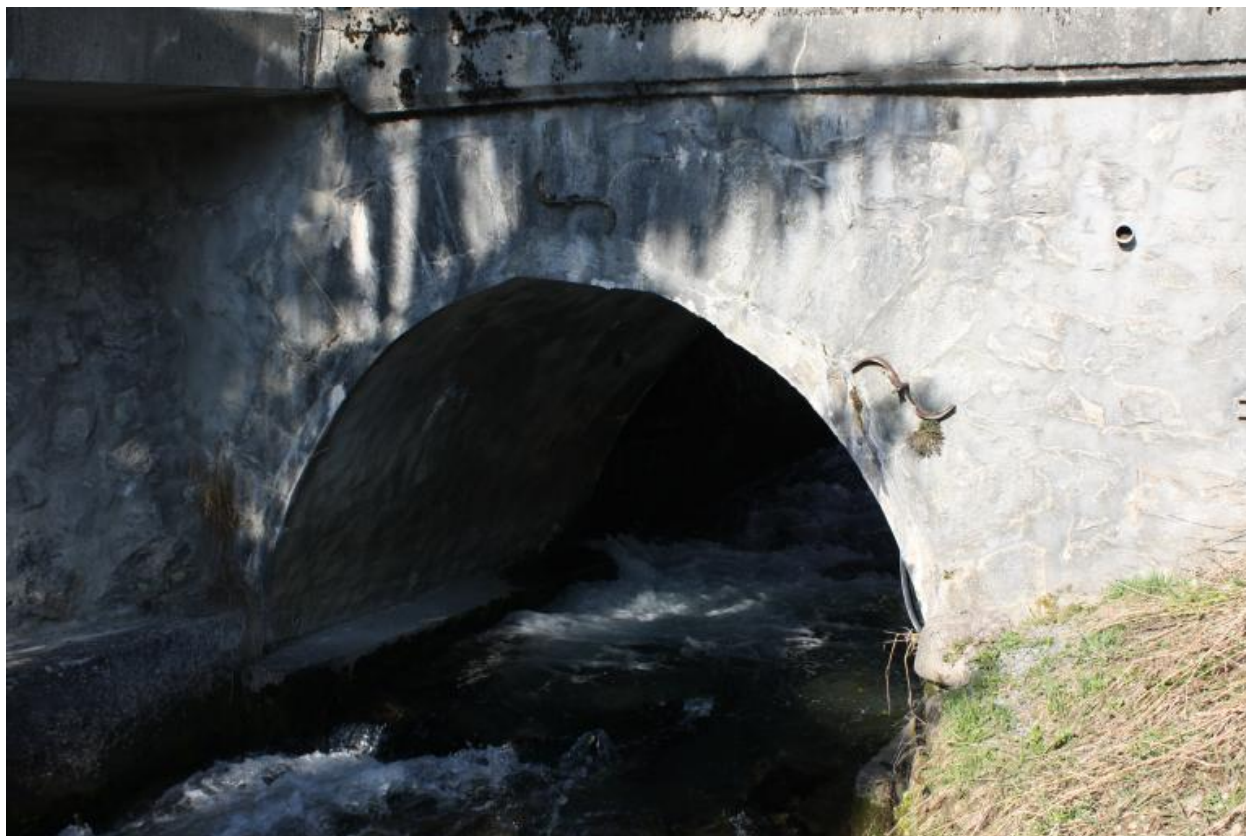
Pont des Filles, détails bandeau et armatures
