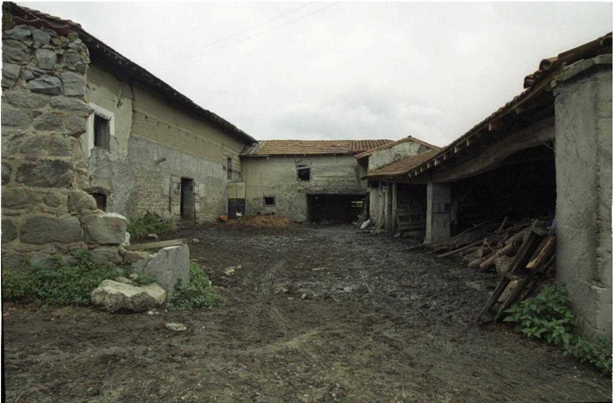
Vue d'ensemble des dépendances depuis l'ouest.
