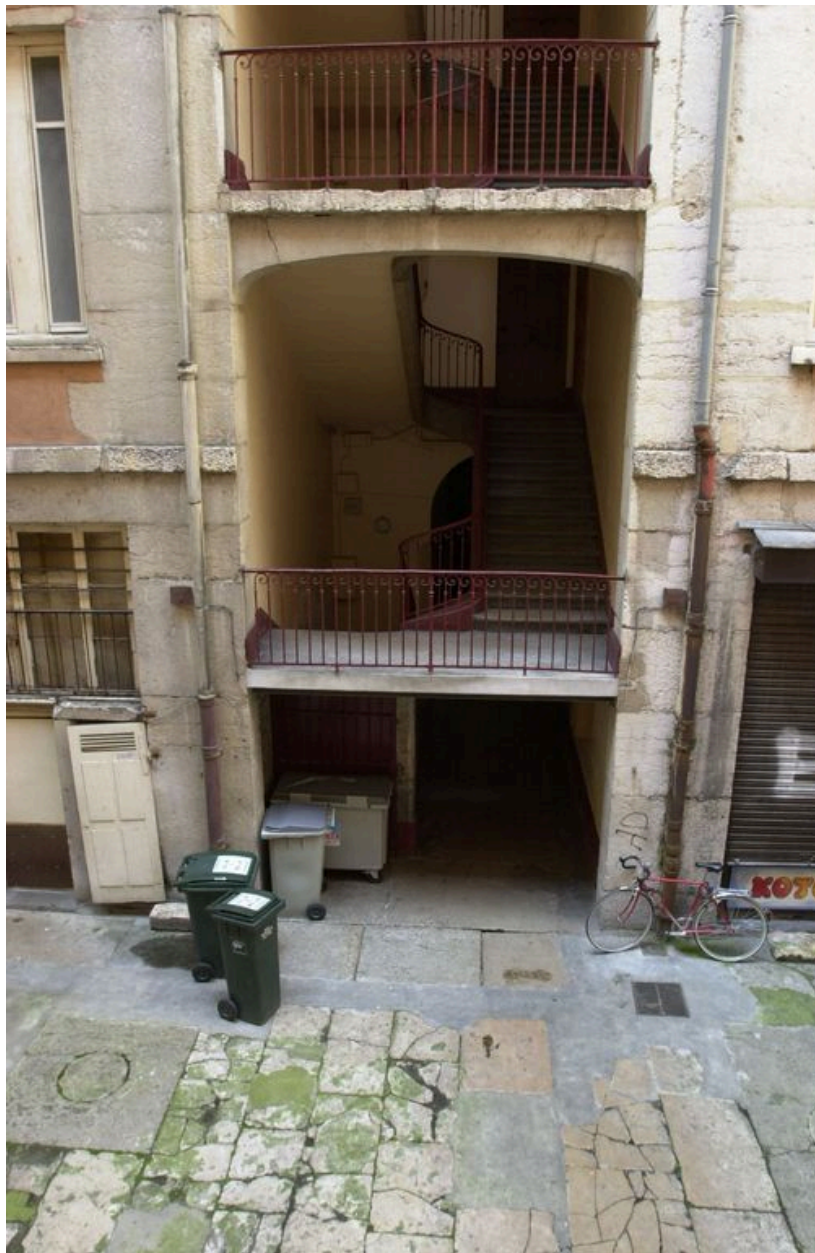
Vue de la cour et de l'escalier en revers de façade au 14 rue Leynaud
