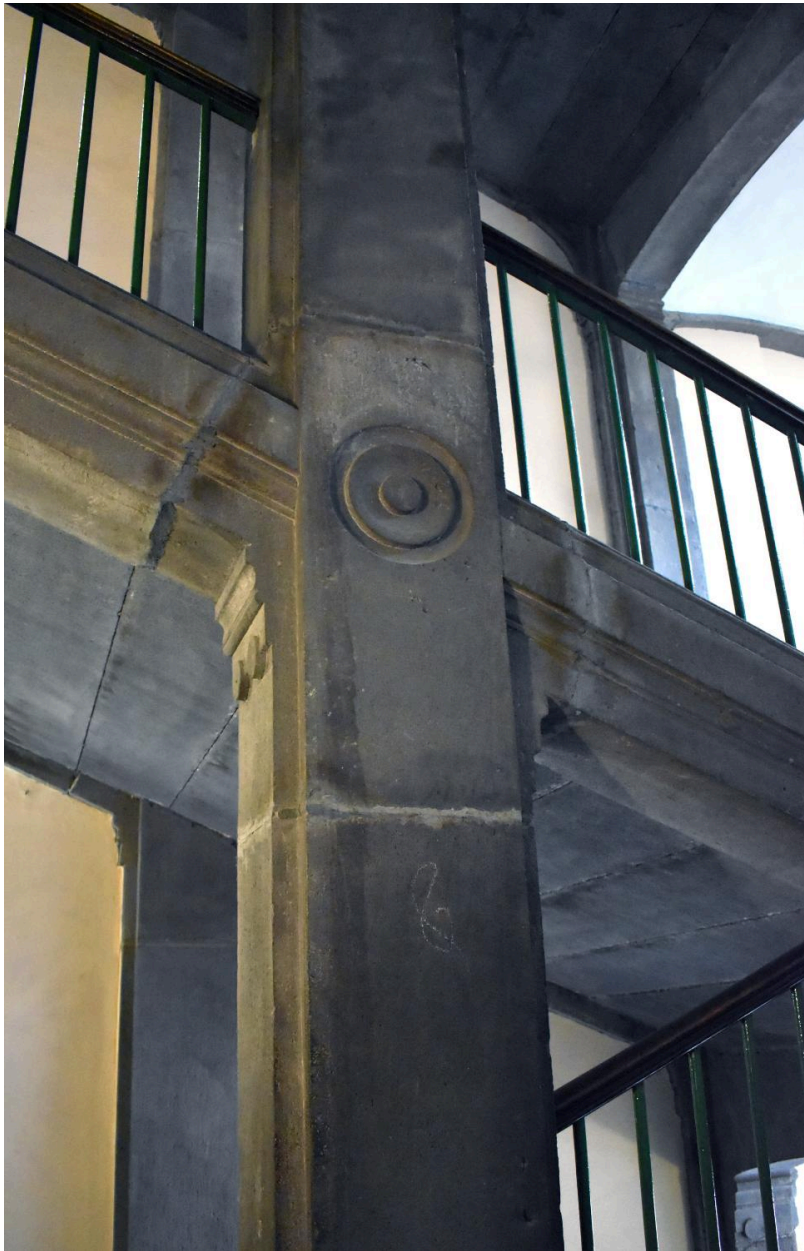
escalier D : détail d'un noyau
