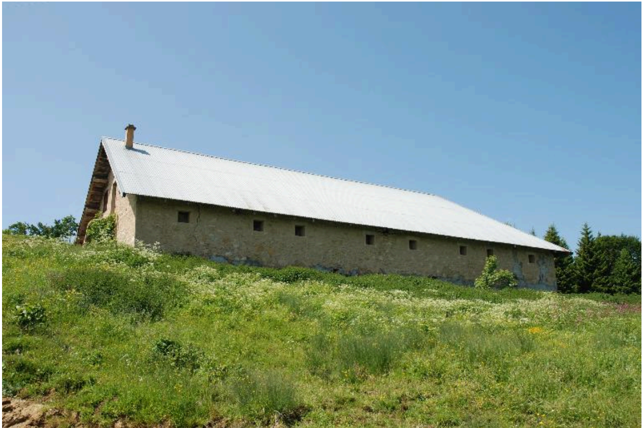
Vue d'ensemble de l'étable nord, depuis le nord.
