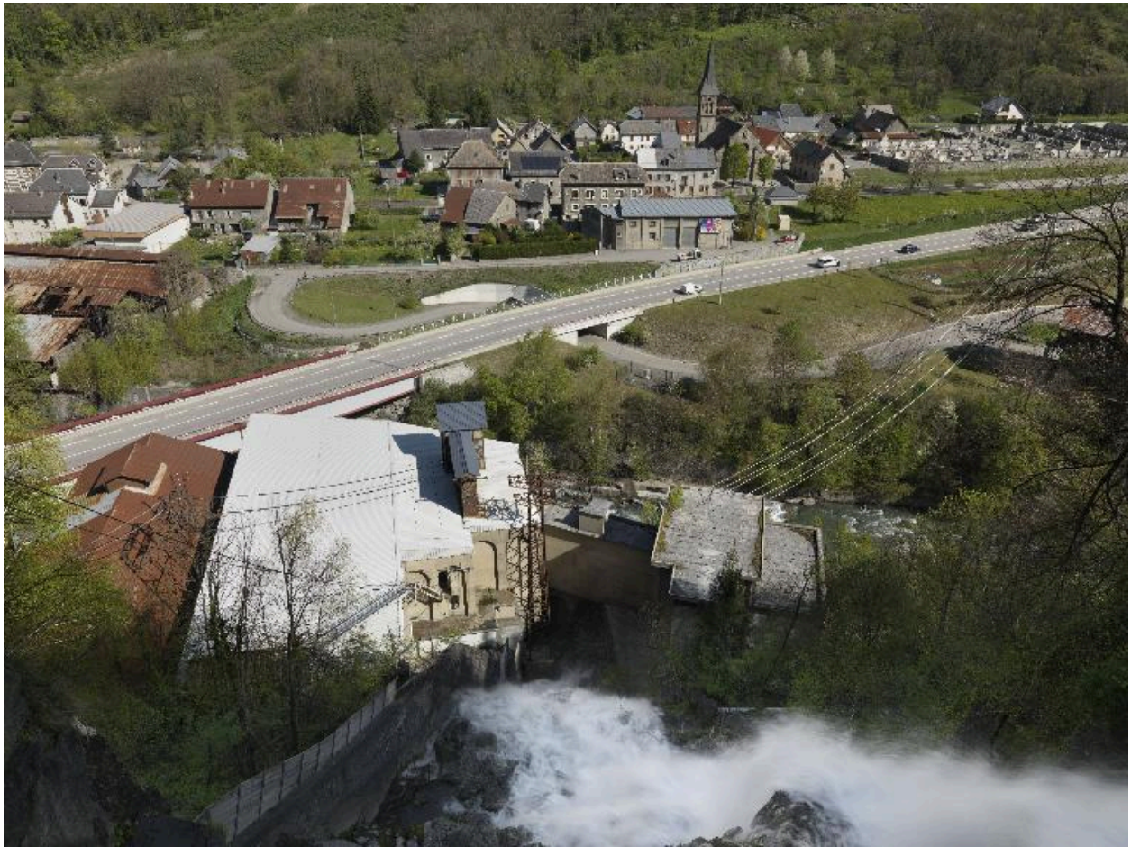
Vue de Livet du haut de la chambre de mise en charge
