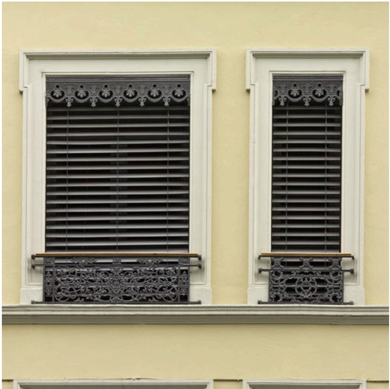
Elévation quai Saint-Antoine : détail de baies
