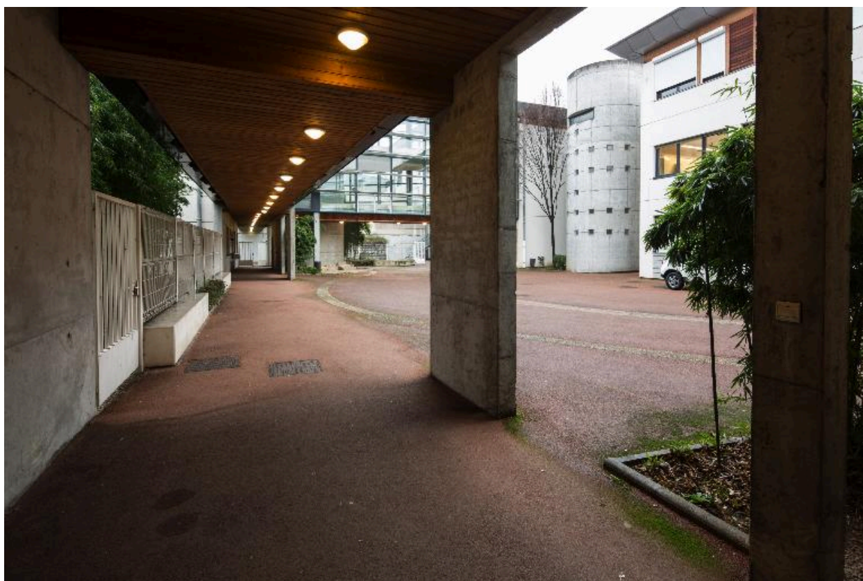
Passage couvert sous la passerelle H
