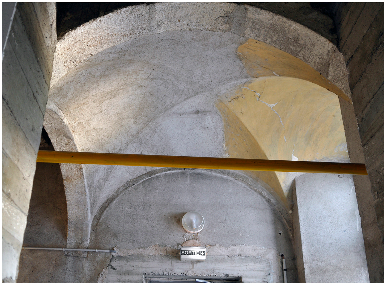
Bâtiment F, rez-de-chaussée : voûte d'arêtes au droit de la 2e volée de l'escalier
