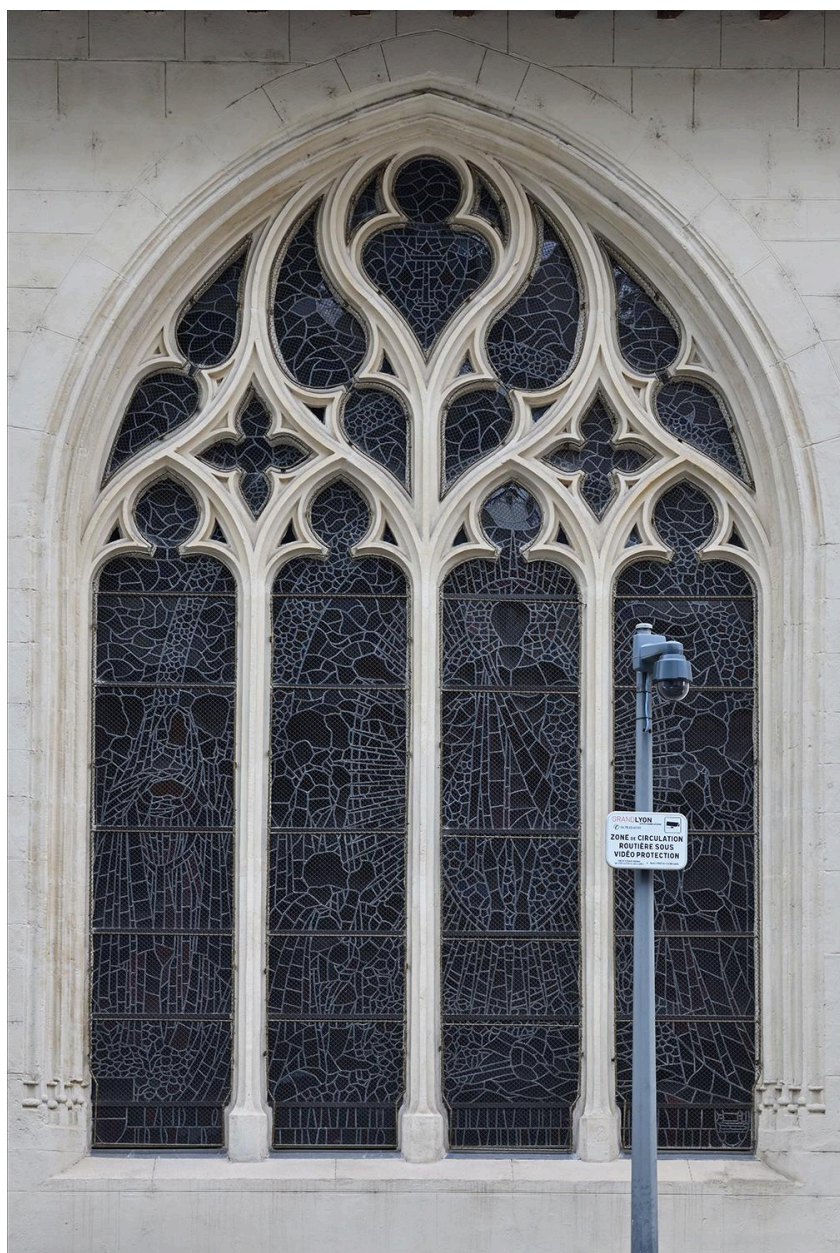
Elévation ouest, baie 3
