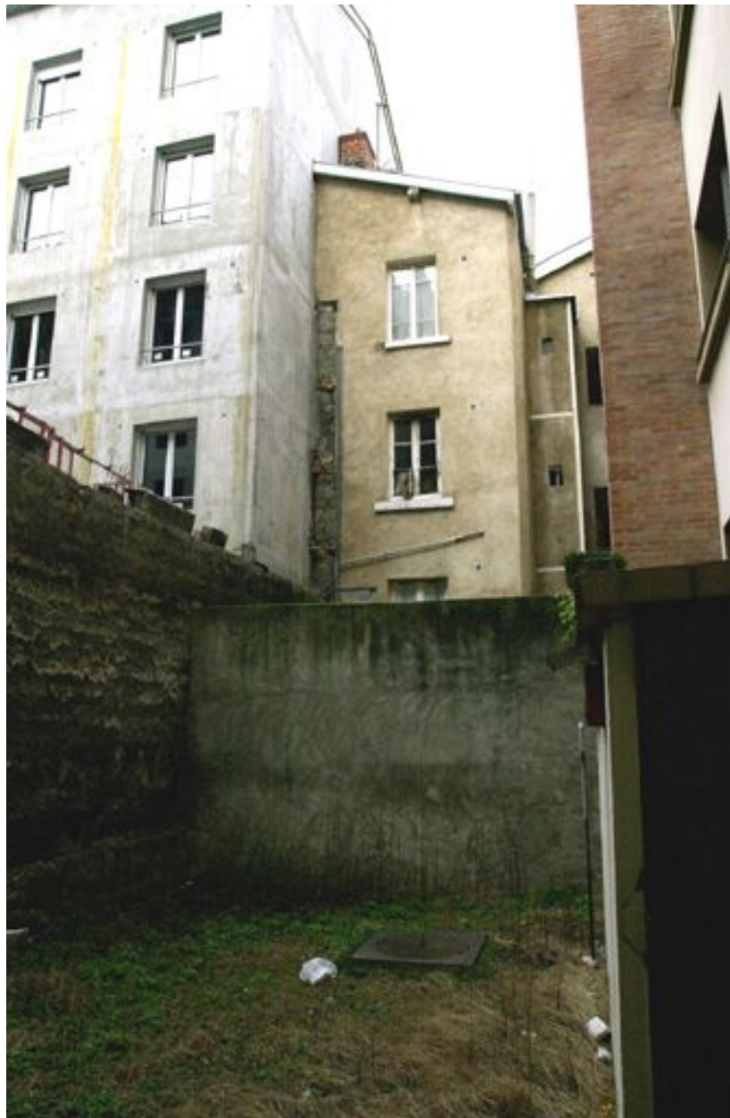
Vue du corps de bâtiment sur cour
