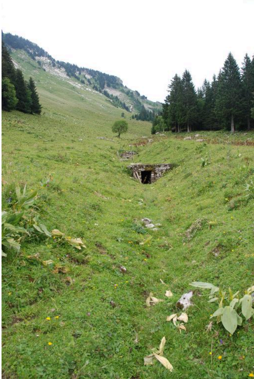
Vue de l'alpage de l'Arclusaz : la prise d'eau.
