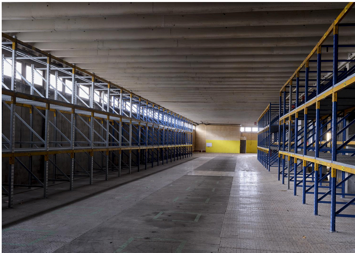
Intérieur de l'atelier V22 : espaces de stockage.
