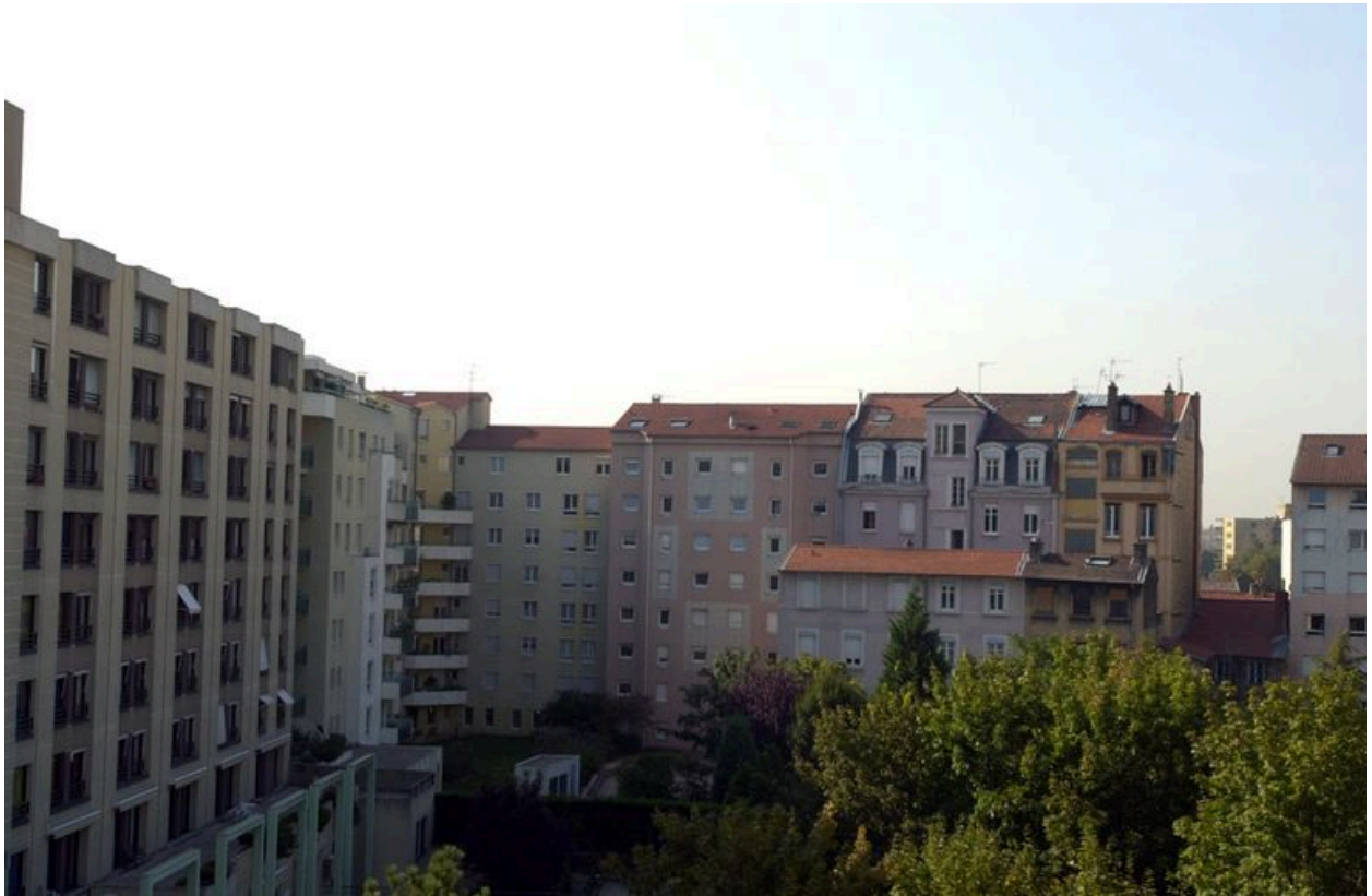
Elévation postérieure, depuis le nord
