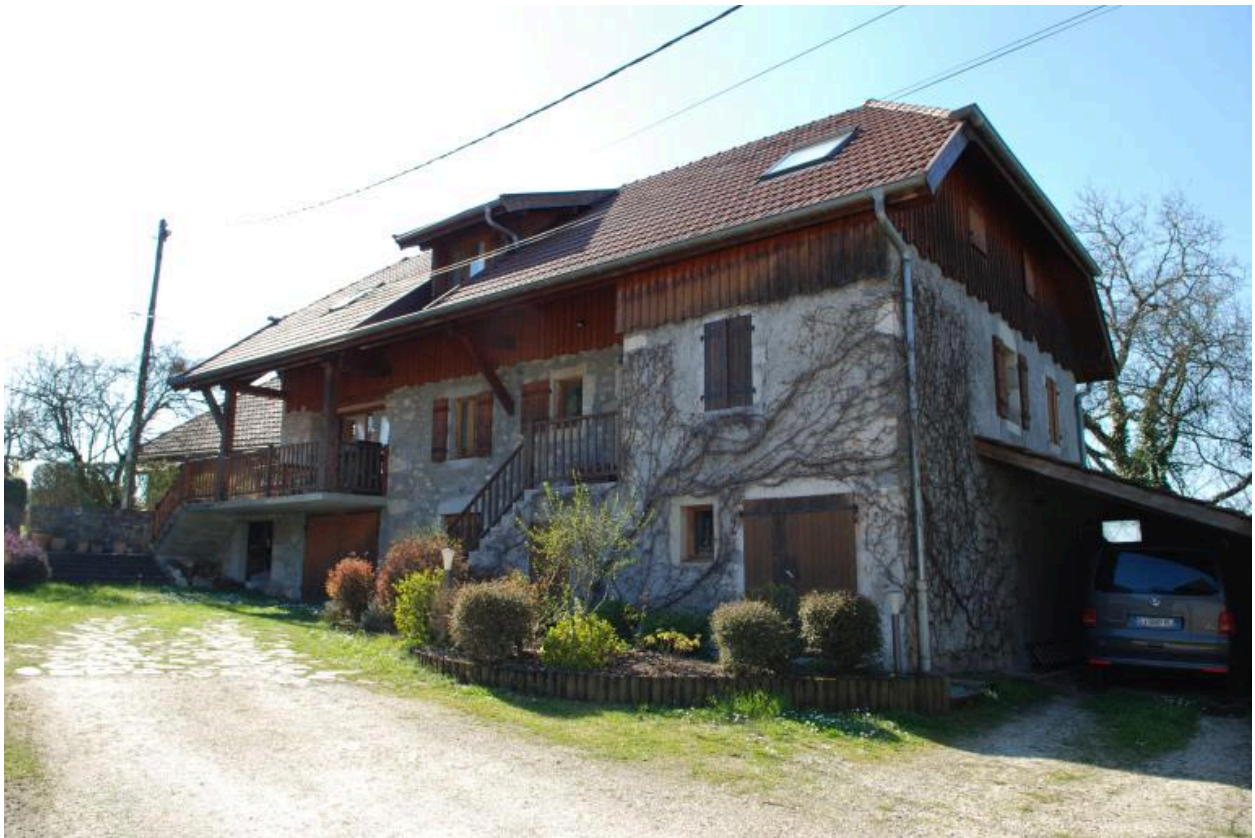
B7 1913, les Crêts-Sud, ferme. Vue d'ensemble de trois-quarts avant droit.
