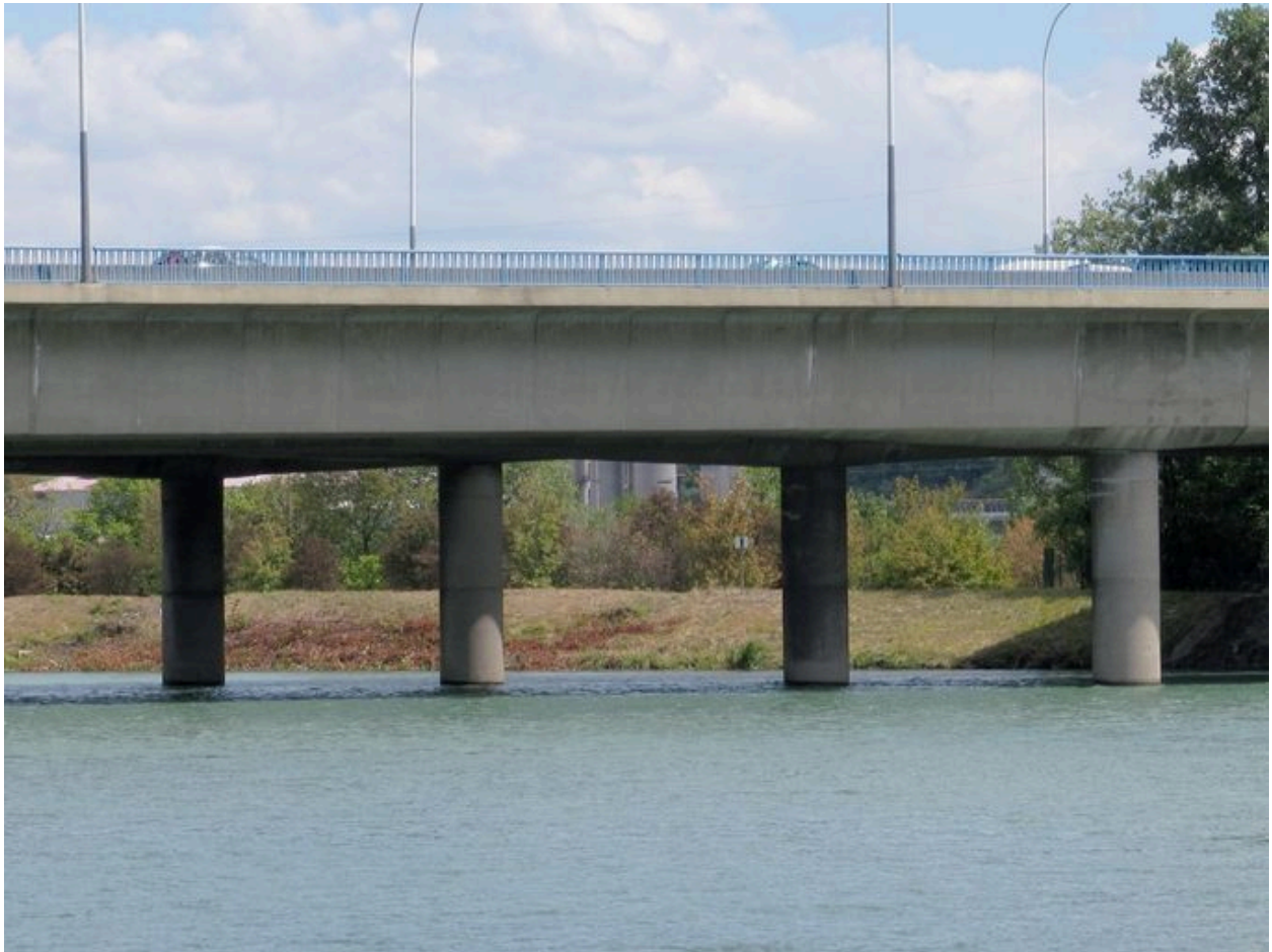
Piles, tablier et parapet, face aval (depuis la rive droite)
