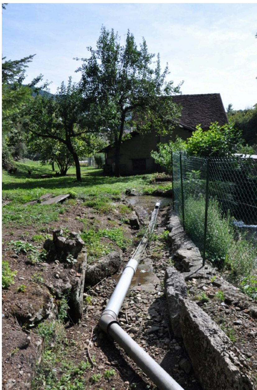
Vue du moulin façade nord avec le canal d'amenée comblé
