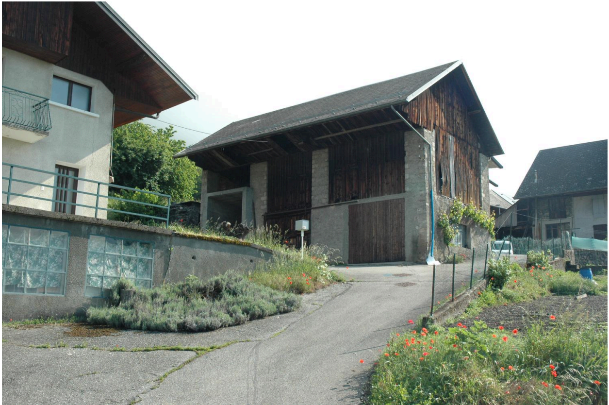
Grange-étable à piliers (2018 B 301).
