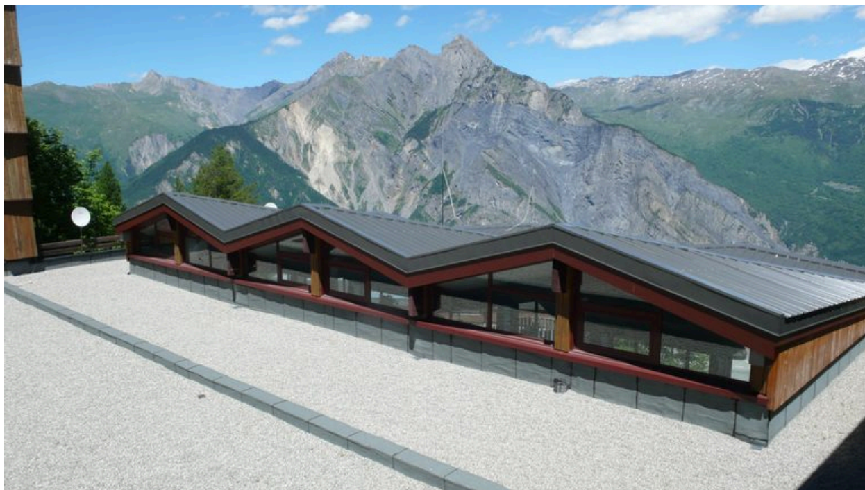
Toit du bâtiment B
