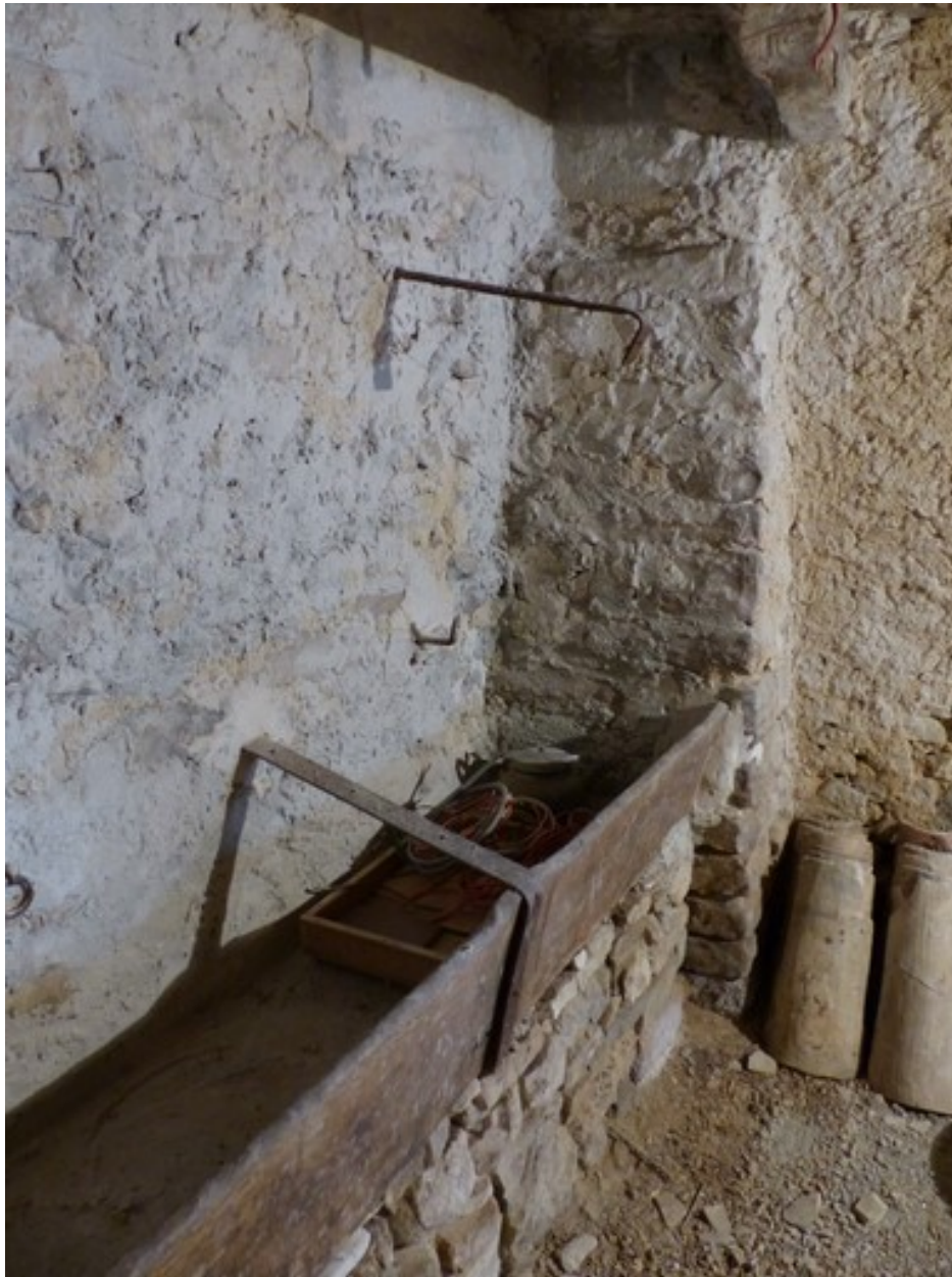
Rez-de-chaussée, étable est. Mur sud, mangeoire.
