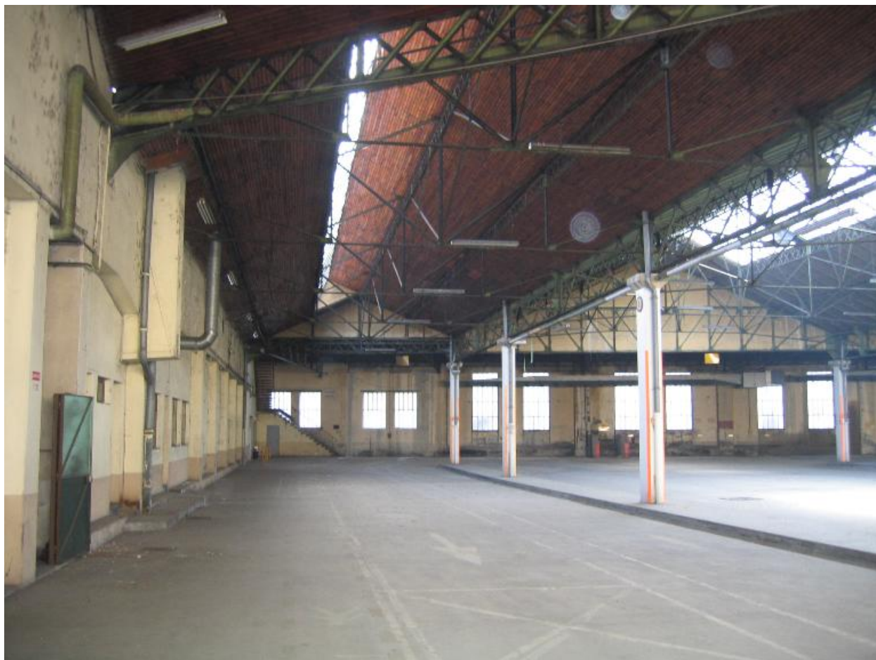
Vue intérieur du dépôt parmentier
