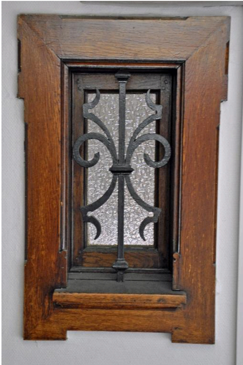
Fenêtre de second jour, ouvrant sur un palier
