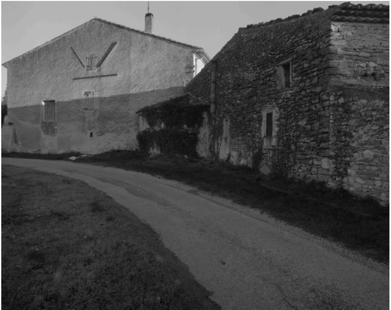
Peyrol (A1 334). Elévations latérale du logis et postérieure des dépendances.
