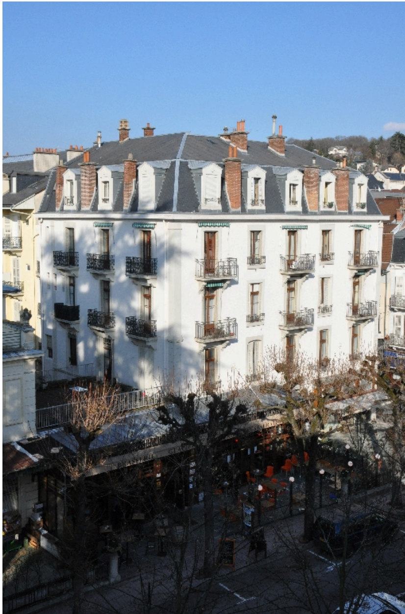
Vue générale depuis le sud-ouest
