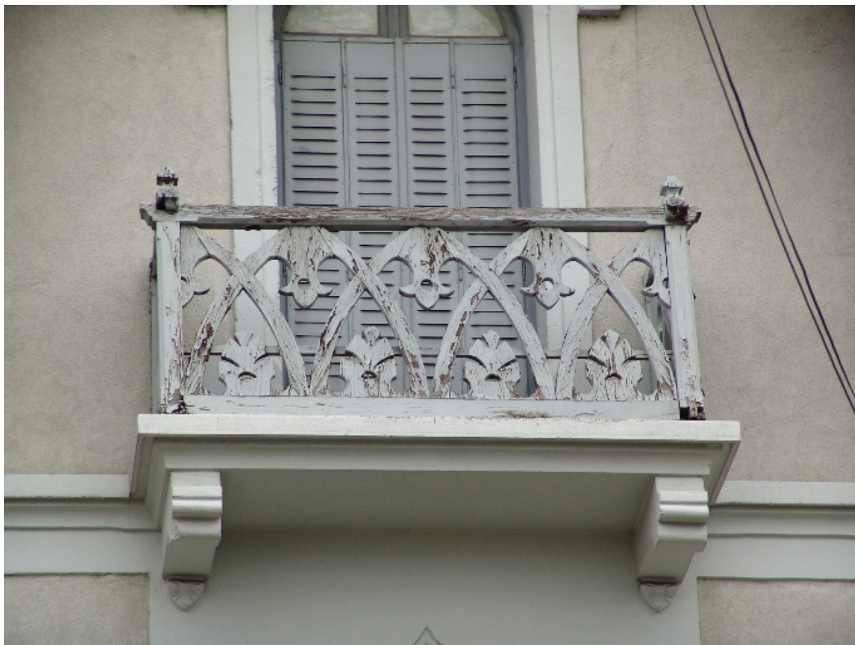
Détail d'un balcon du pignon
