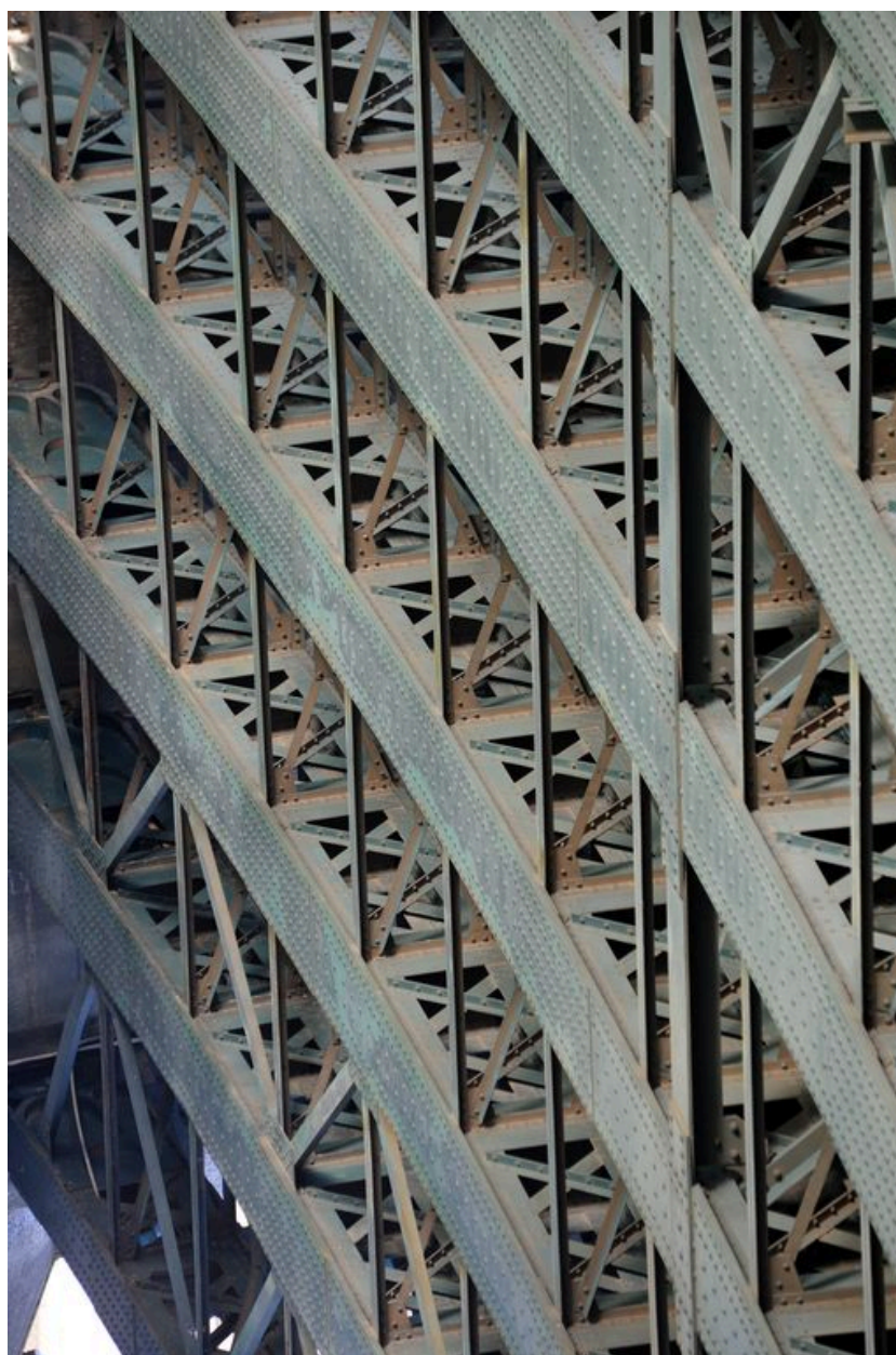
Structure métallique de l'arche, de dessous, vue de détail (depuis la rive gauche)
