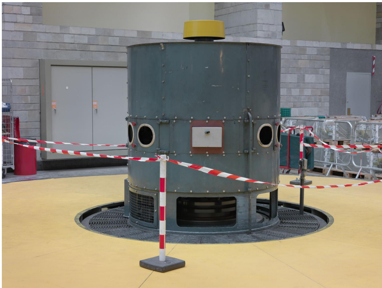
Tête de machine avec le capot bleu (esthétique) démonté
