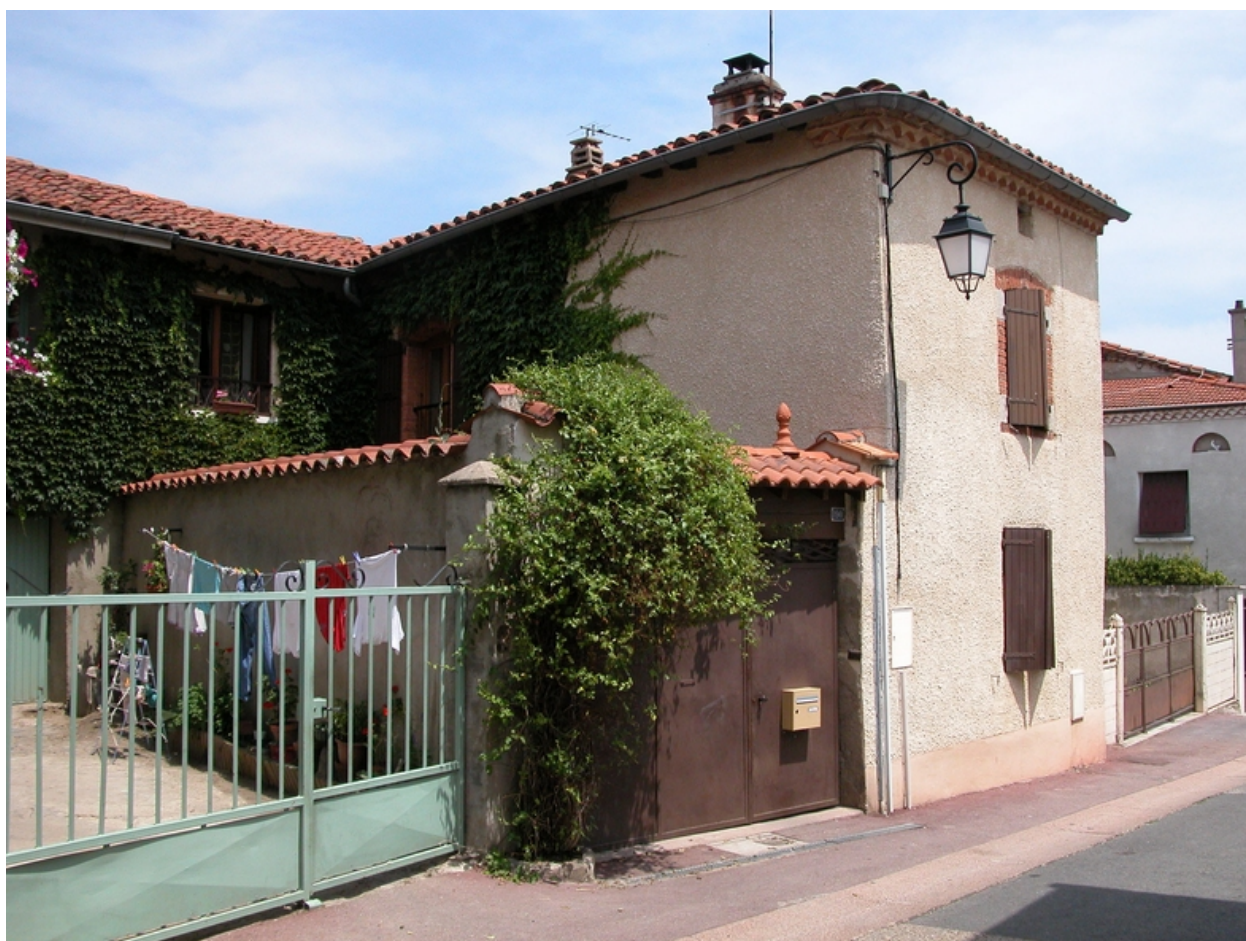
Faubourg de la Sablière. Ferme, puis maison (1999 AB 132 à 134, rue de l'Arzalier).
