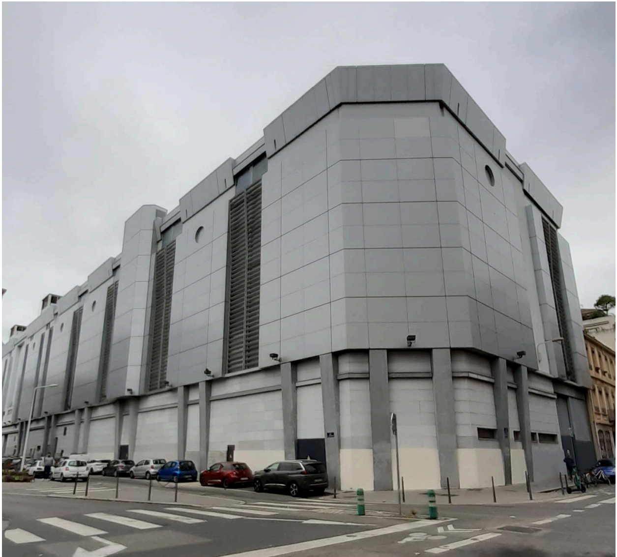
Vue d'ensemble poste de transformation Saint-Amour
