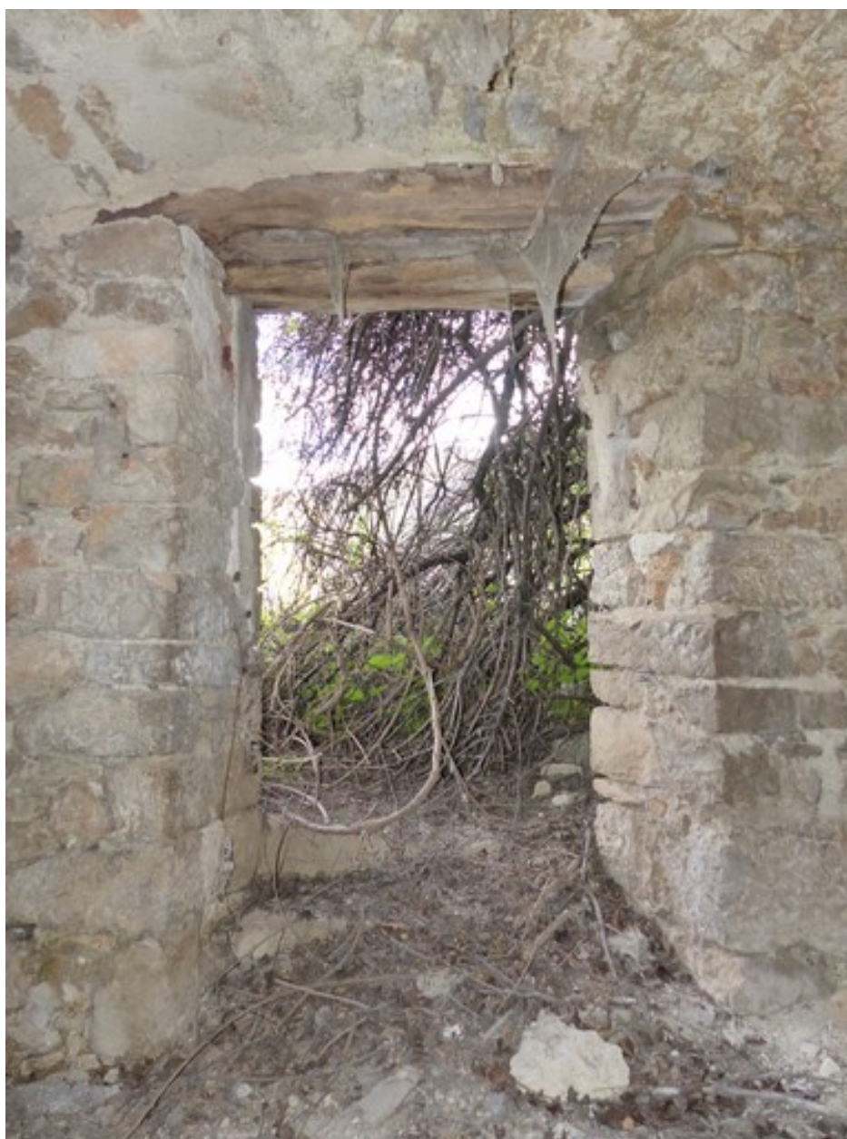
Etage de soubassement, mur sud. Porte.
