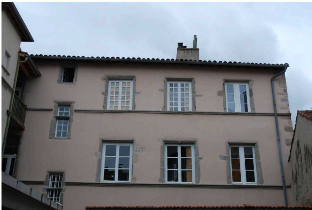
Vue partielle de l'élévation postérieure sur cour.
