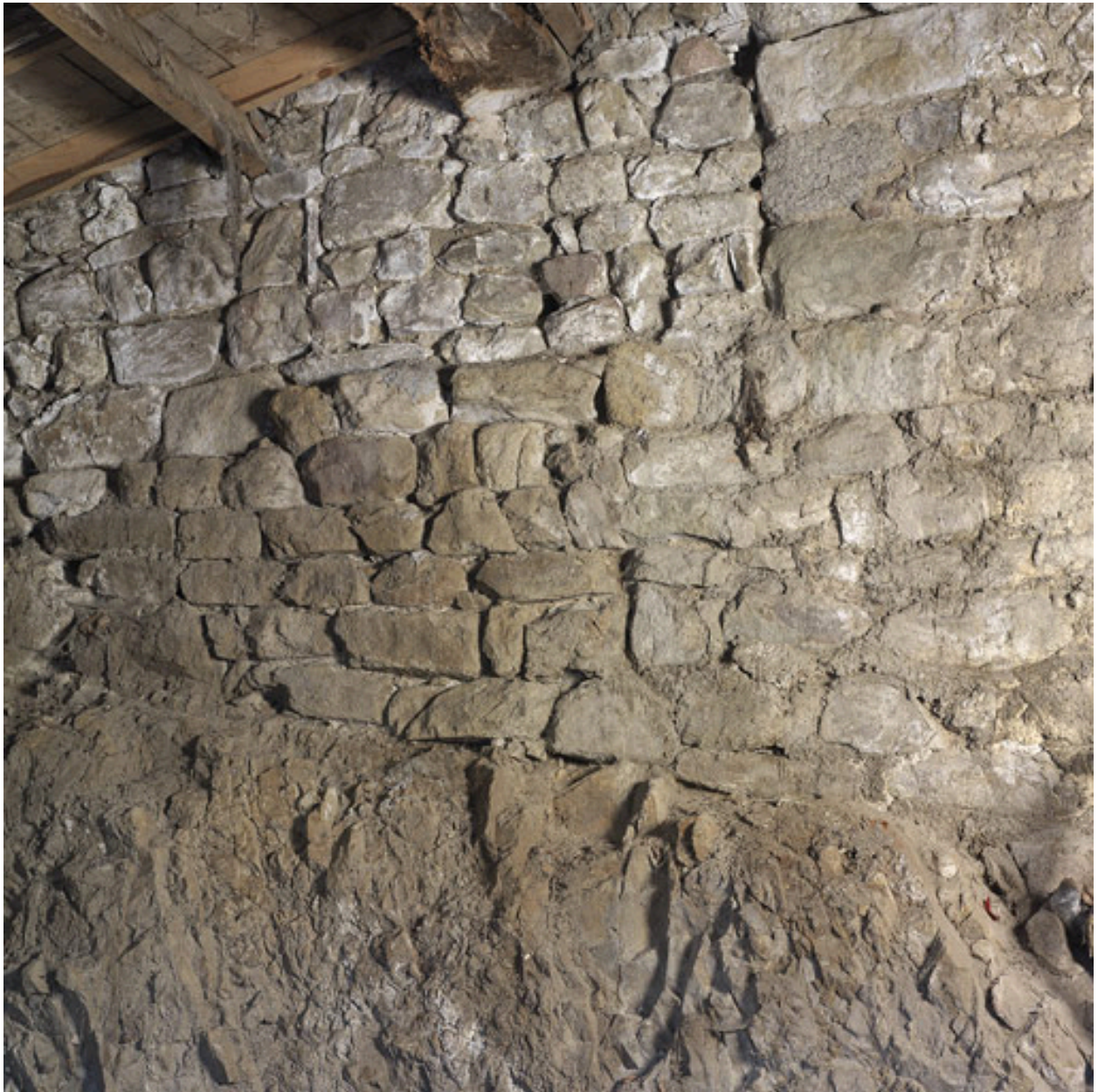
Vue intérieure du rez-de-chaussée surélevé du bâtiment nord-est : détail de matériaux.
