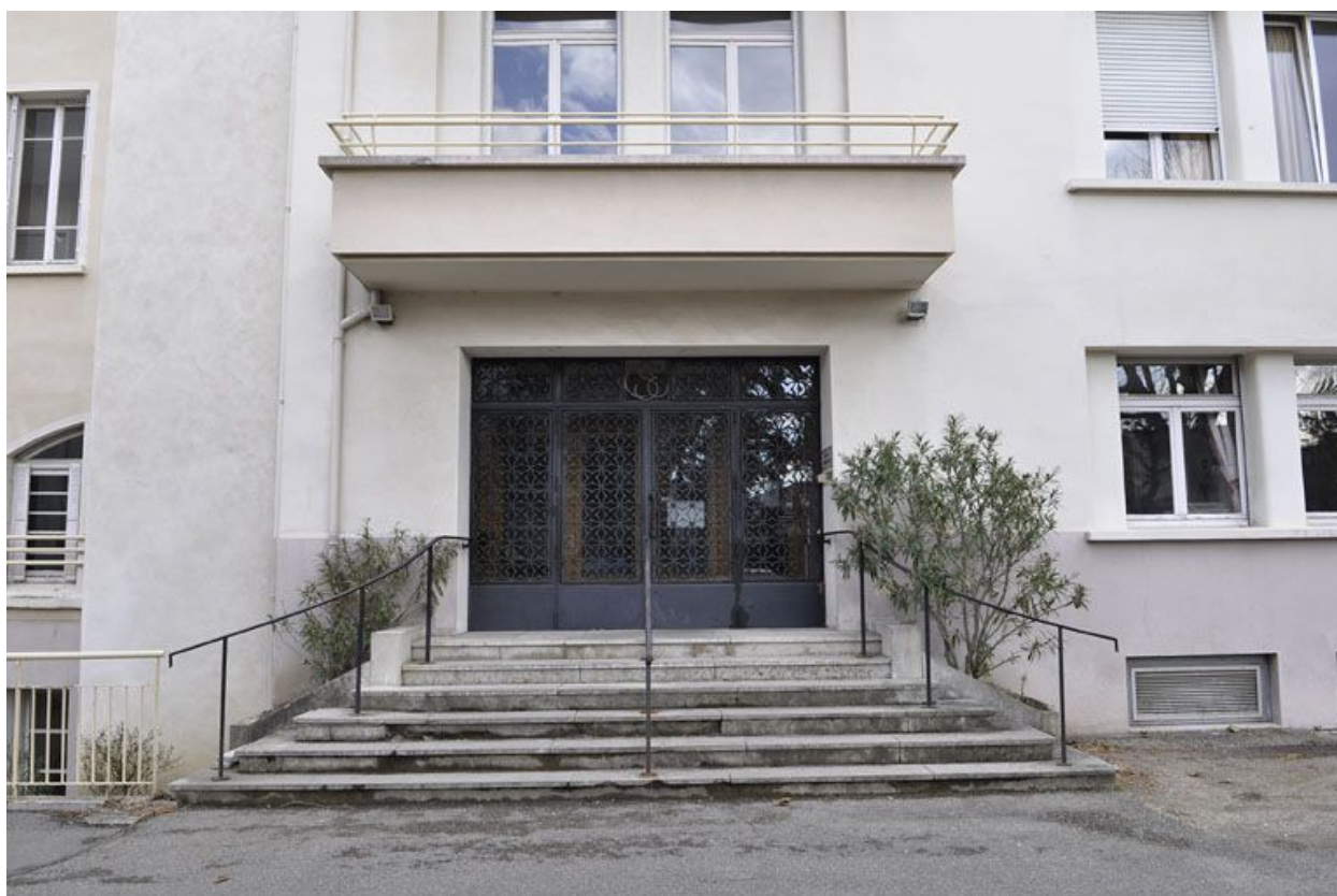
Aile sud, façade principale, détail : porte d'entrée.
