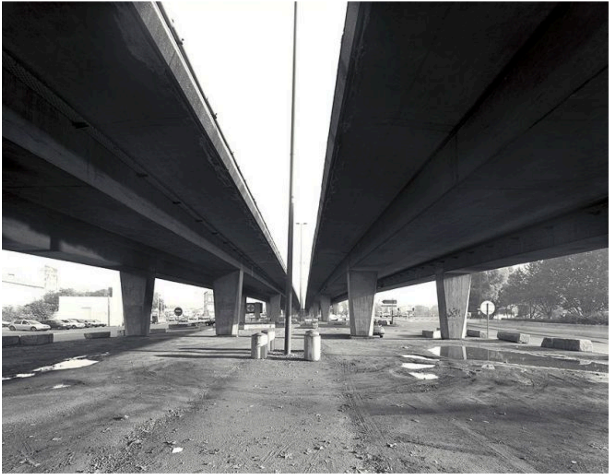
Le dessous du pont depuis le nord
