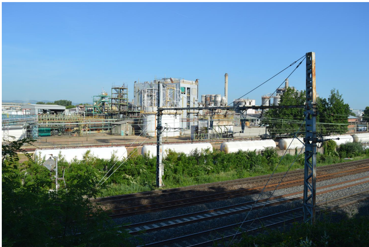
Vue côté raccordement ferroviaire
