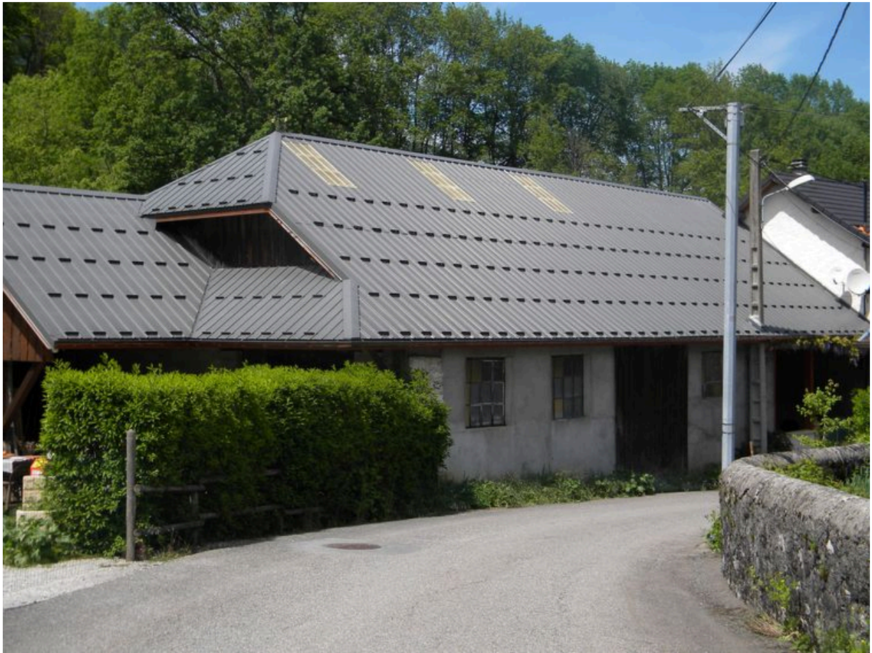
Façade sur rue d'une ancienne scierie le long de l'Ire (2008 C8 2755)
