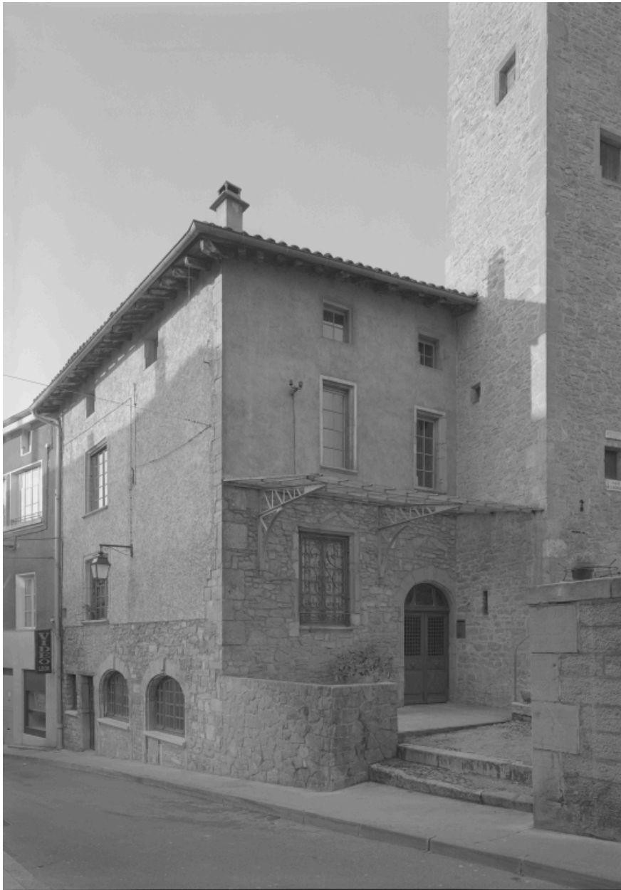
Maison partagée (type IV), 41 Grande rue-place de l'Horloge : élévations sur la place de l'Horloge et la rue de l'Herberie, vue de trois quarts.
