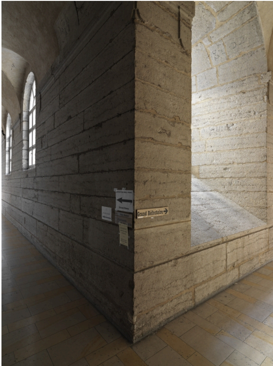
Bâtiment I. Angle nord-ouest des galeries
