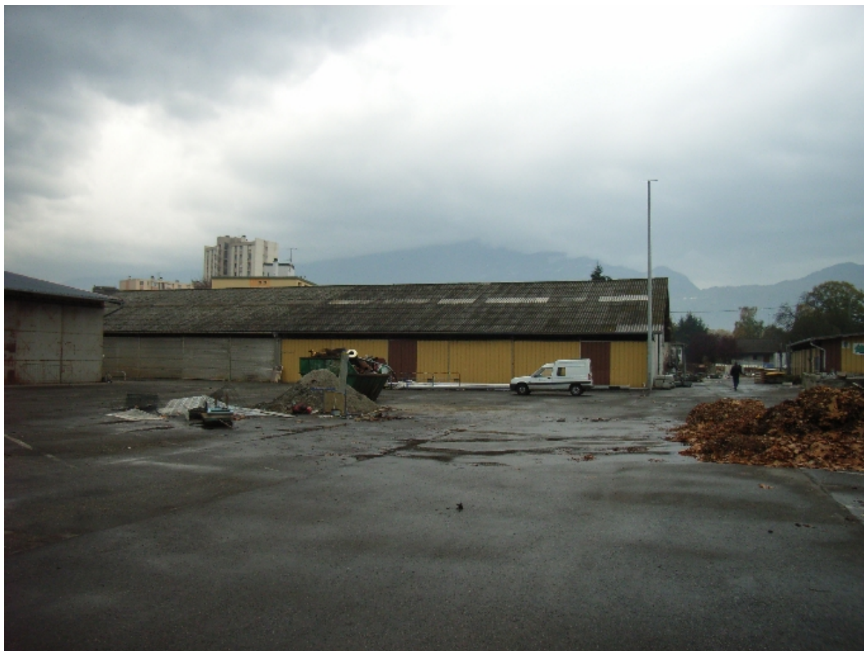
Elévation postérieure de la grande halle
