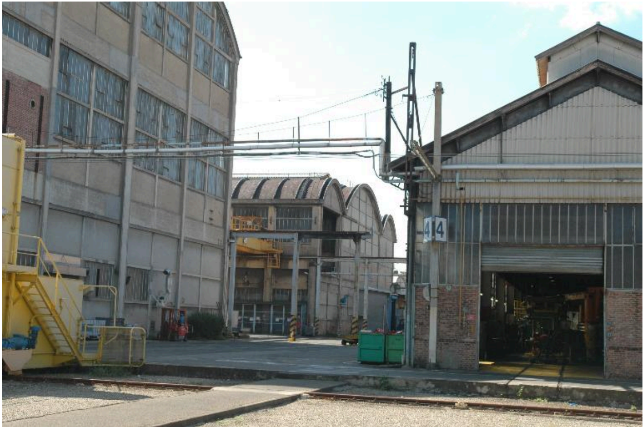
Vue extérieure des ateliers
