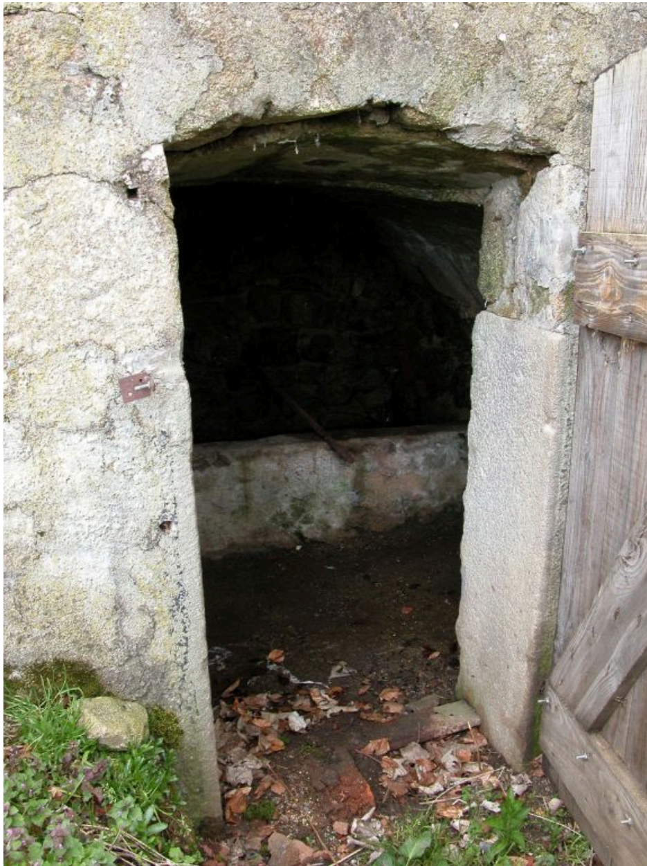
Détail de l'espace réfrigéré.
