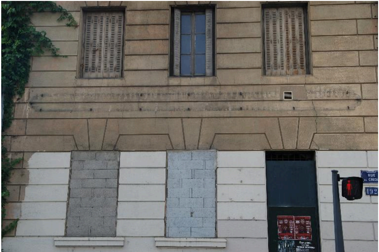
Vue rapprochée de l'élévation est, sur la rue de Créqui : inscription partiellement lisible
