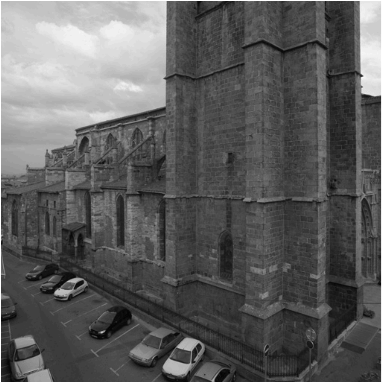
Vue d'ensemble de l'élévation nord.
