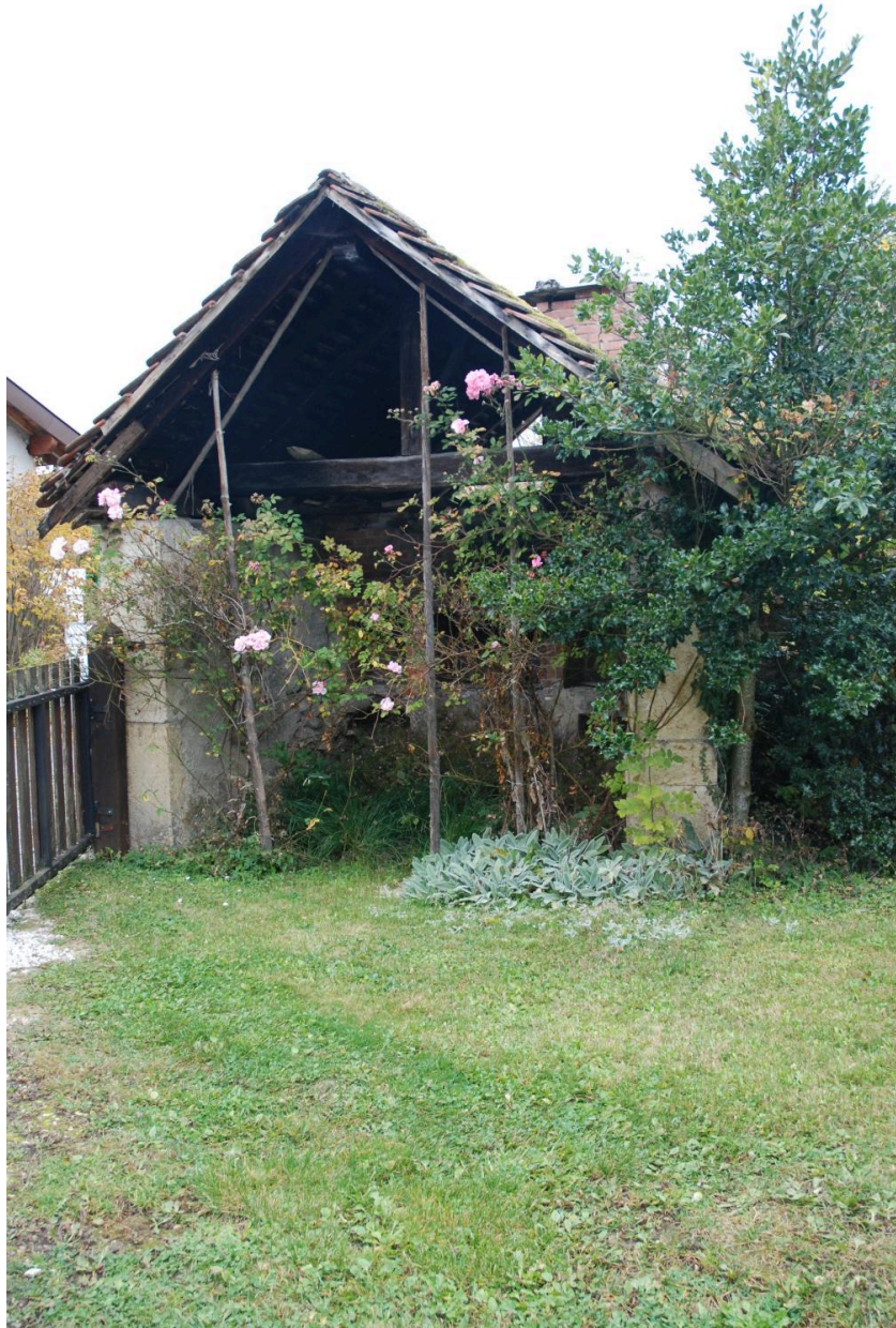
Vue d'ensemble du bâtiment.
