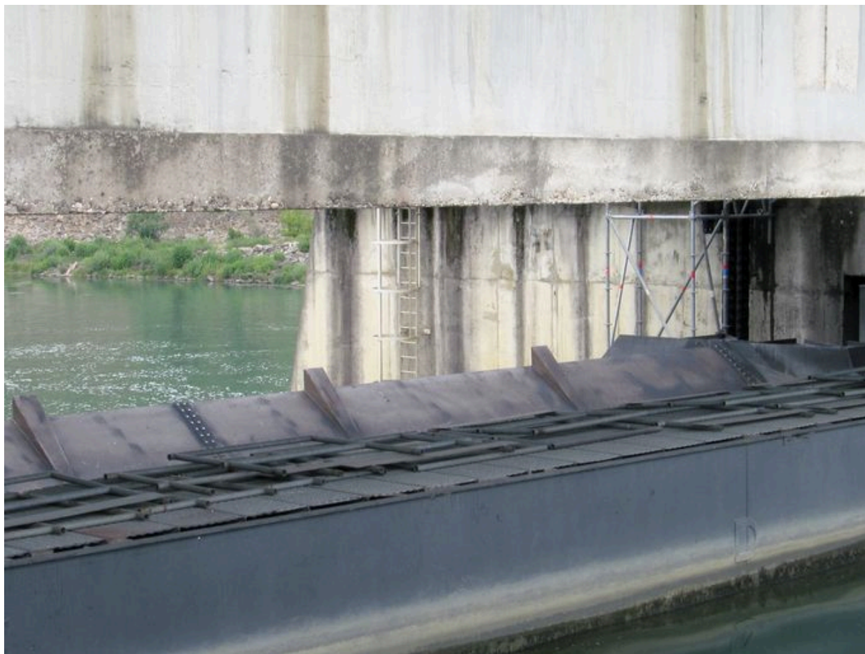
Détail d'une passe du barrage, face amont (depuis la rive gauche)
