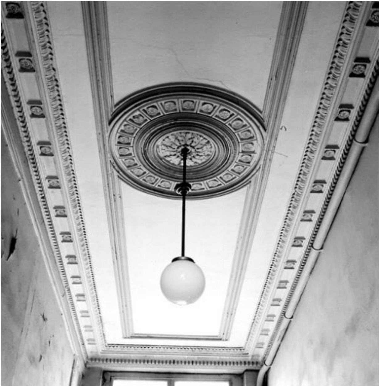
Vue du plafond du vestibule
