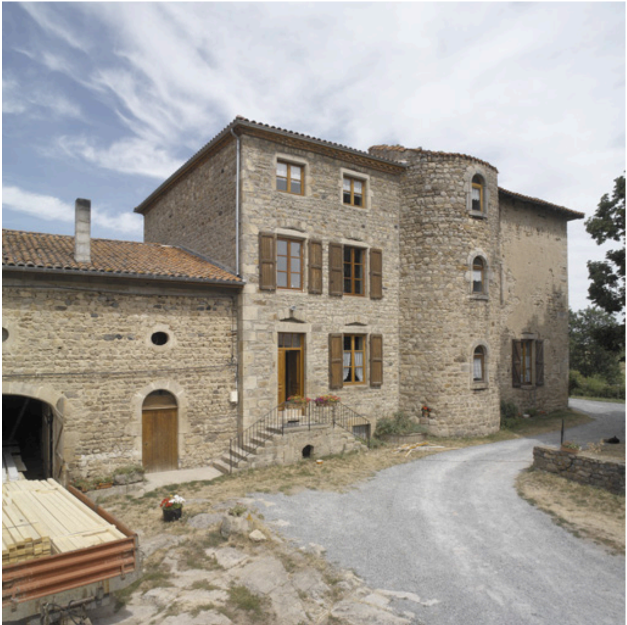
Vue d'ensemble depuis l'ouest : logis adossé à la maison forte, partie sud de la grange-étable.
