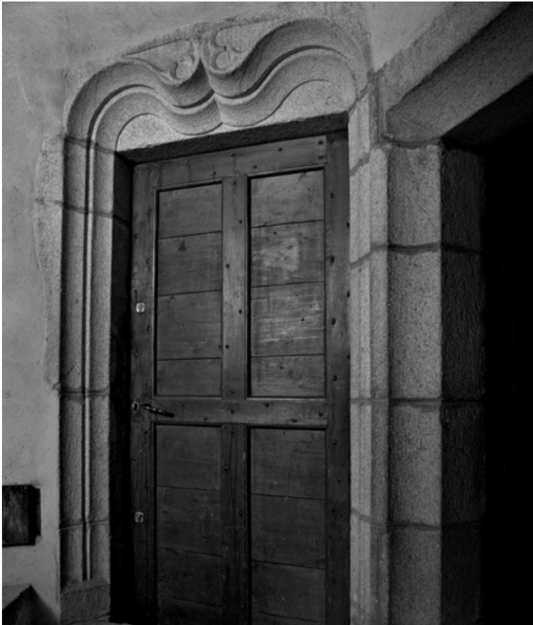
Détail des deux portes de l'escalier en vis de l'aile ouest, au premier étage.
