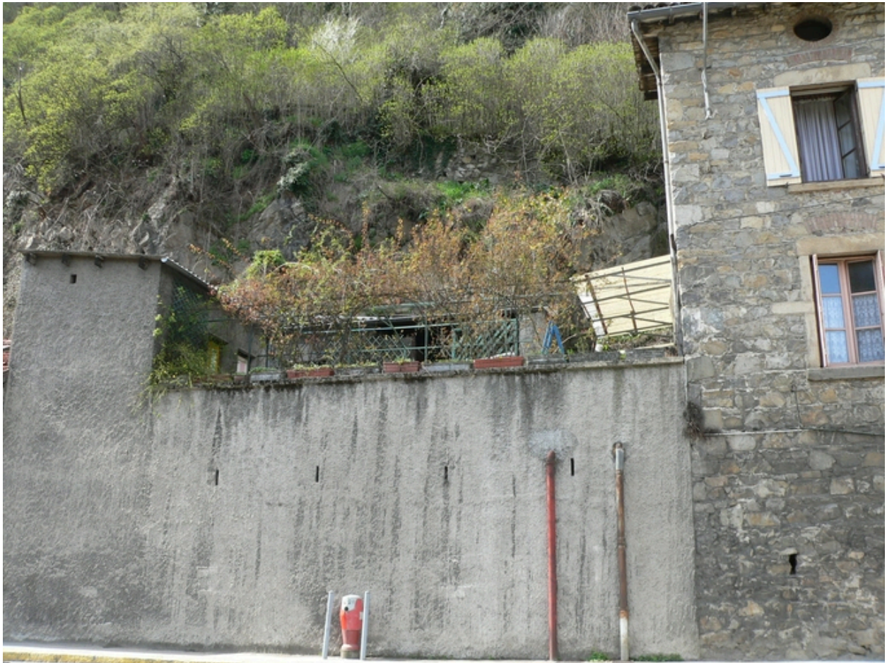
Mur de soutènement
