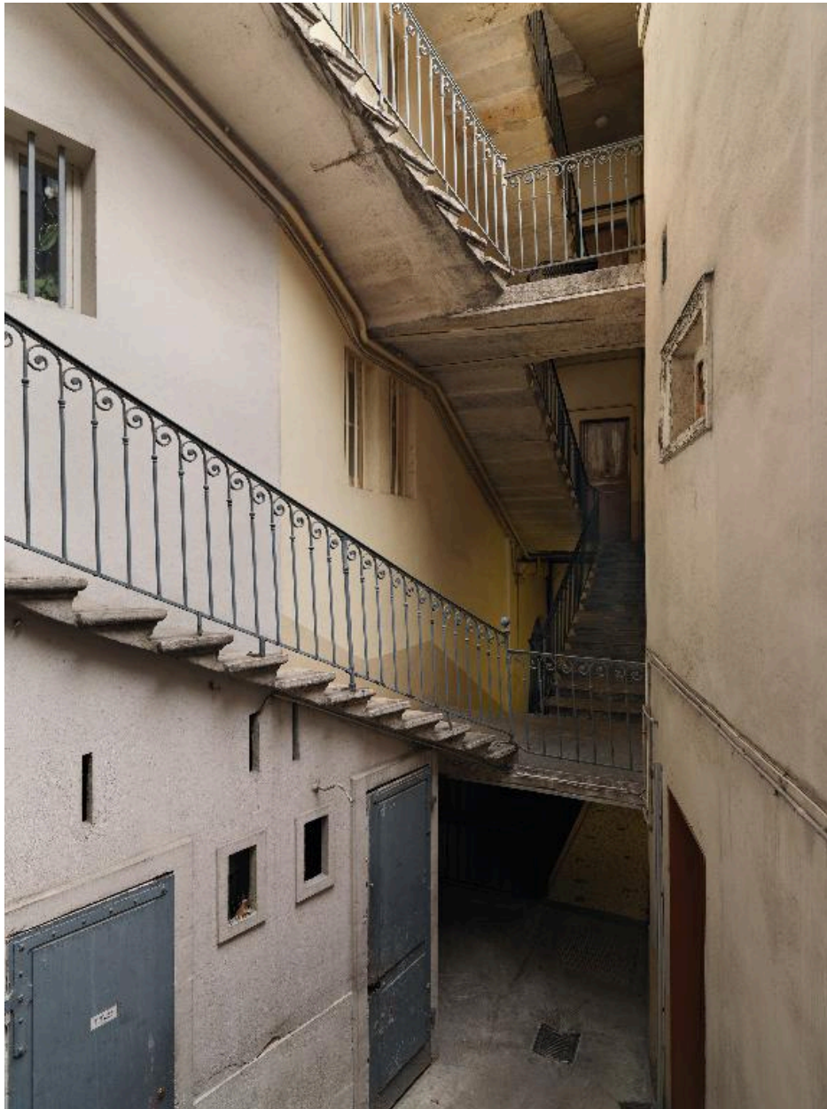
Vue générale de l'escalier depuis la cour
